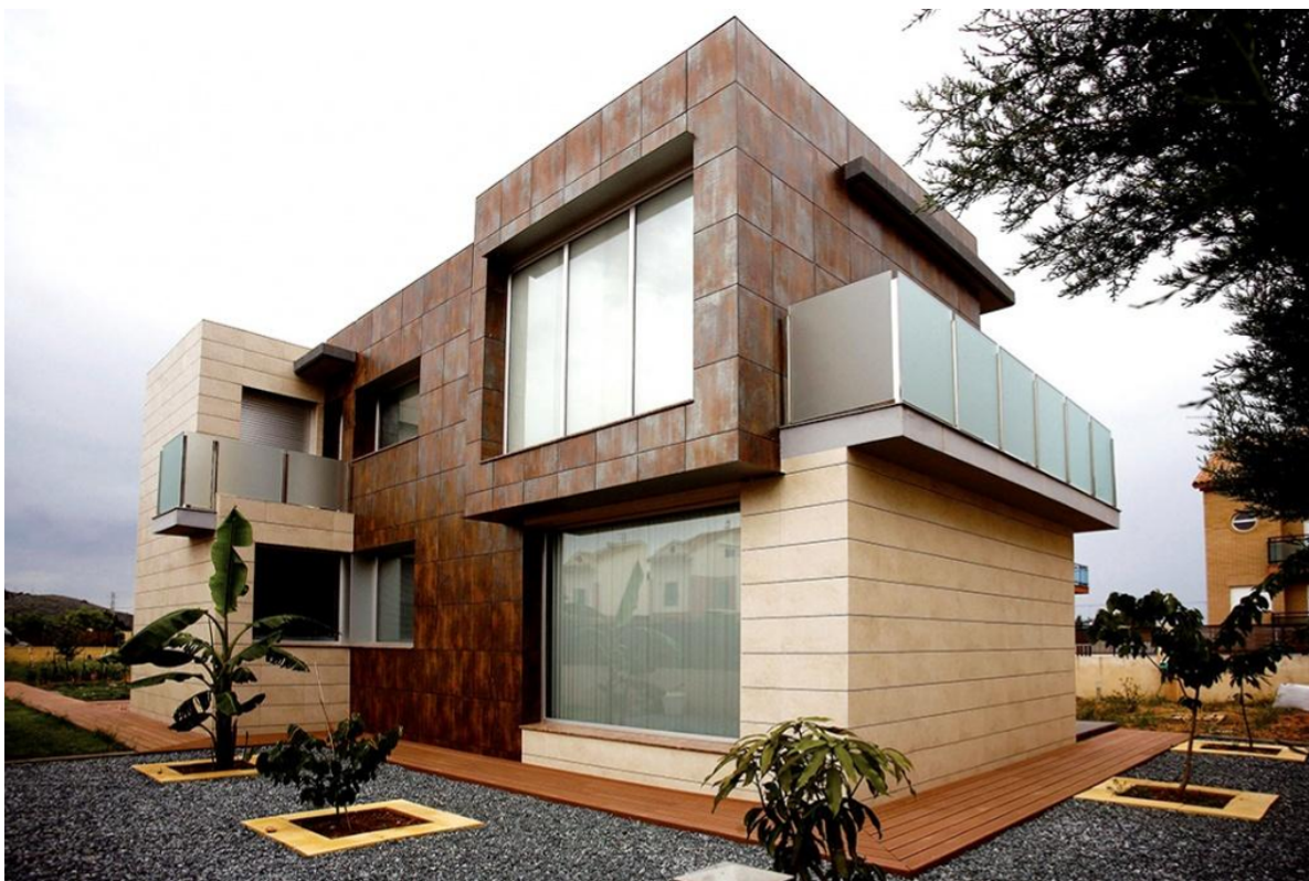
Рисунок 5 – Пример вентилируемого фасада из керамогранита
